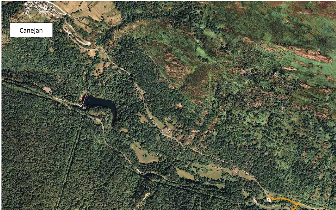
Imatge 01. Situació del poble de Canejan on s'emplacen els treballs a realitzar en el vial d'accés.
